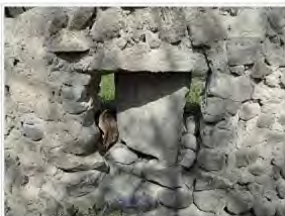
در سنگی قدیمی که در گذشته استفاده میشده است بعد ها اکثر در های سنگی جای خود را به درب چوبی دادند و امروزه در های فلزی جایگزین در های چوبی شدند.
