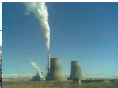
بناب- نیروگاه برق
