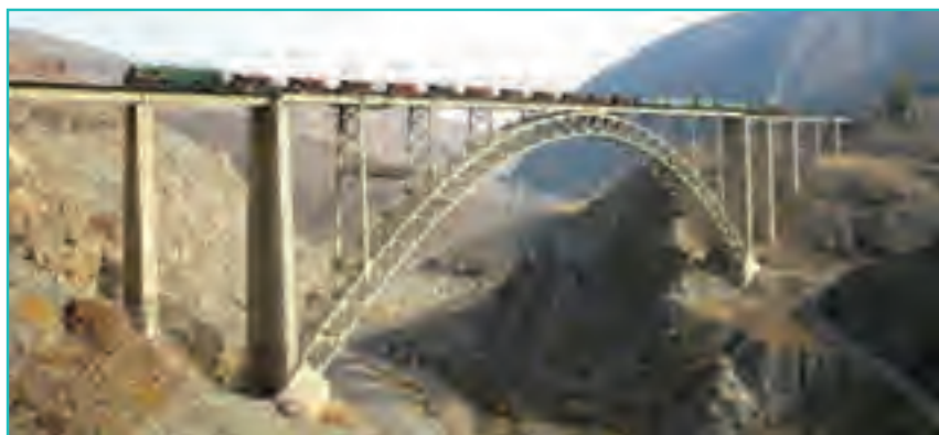
شکل ۶۶-۵- پل هوایی قطور- خوی
