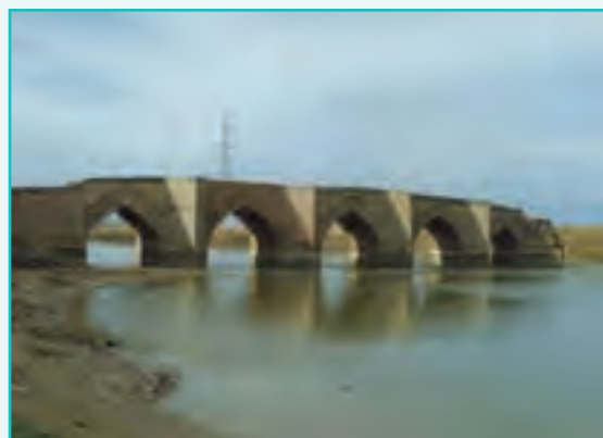
شکل ۲۶-۵- پل میرزا رسول در میاندوآب
