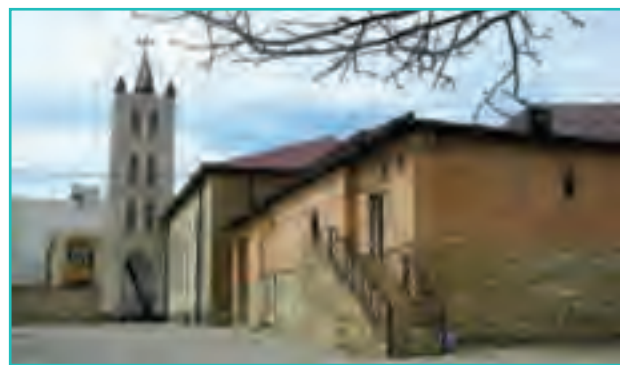
شکل ۳۹-۵- کلیسای ننه مریم - ارومیه
