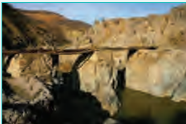
شکل ۲۷-۵- پل قالاتاسیان سردشت
