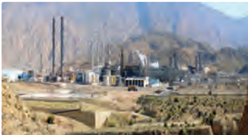
شکل ۱۲-۱۳- تأسیسات گازی پارس جنوبی
