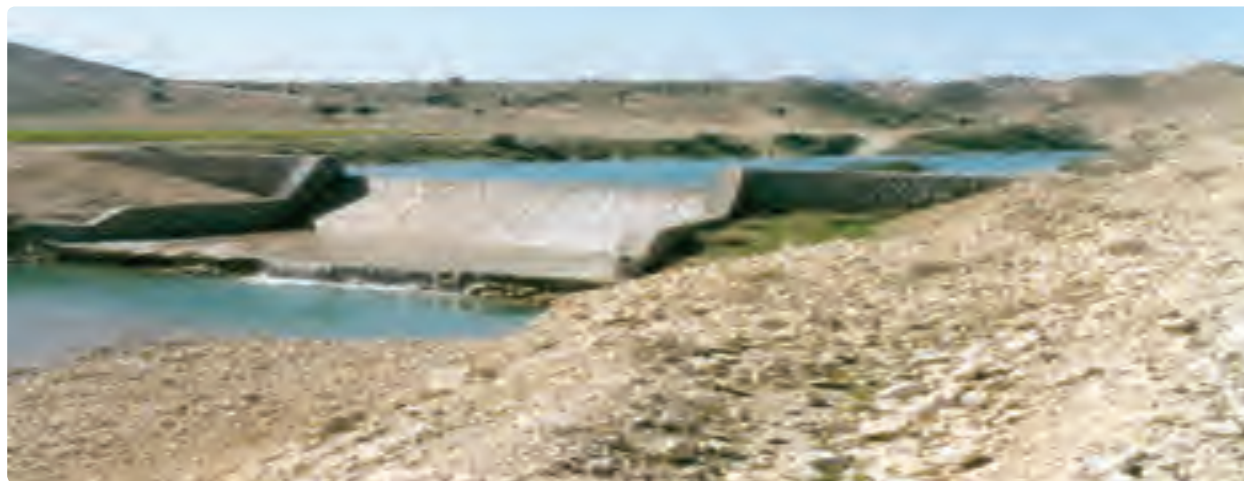
شکل ۱۳-۱۴- احداث استخرهای ذخیره آب
