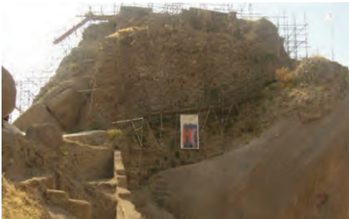
شکل ۲-۴- قلعه حسن صباح الموت، در حال مرمت
