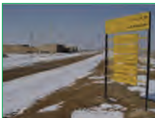
شکل ۶-۶- پروژه احداث راه روستایی - آق تپه
