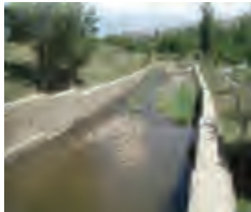
شکل ۱-۶۴- دیوار حاشیة رودخانه
