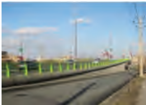
شکل ۱۰-۶- پل روگذر رسالت - همدان
