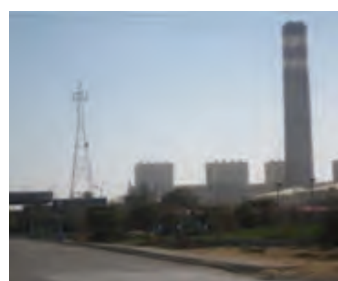
شکل ۱۹-۵- نیروگاه برق شهید مفتاح - فامنین
