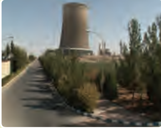
شکل ۱۰-۶- نیروگاه سیکل ترکیبی
