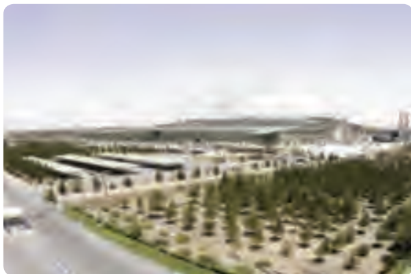
شکل ۹-۶- شرکت فولاد آلبازی اشکذر
