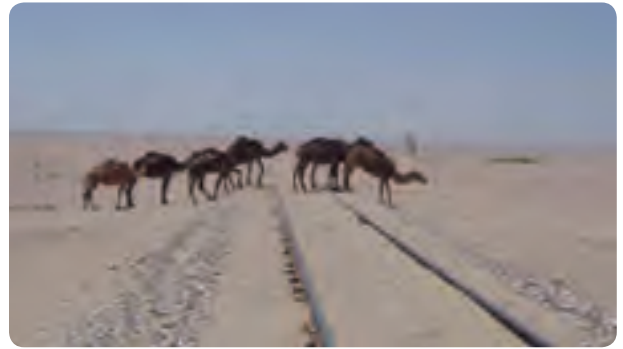
شکل ۱-۴۳- هجوم ماسه‌های روان به خطوط راه آهن در مسیر بافق
