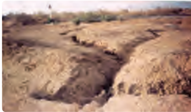
شکل ۵۴-۱- پدیده فرونشست در منطقه رضوان شهر
