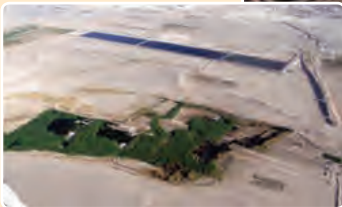
شکل ۳۷-۱- تصویر هوایی برکه‌های تصفیه خانه فاضلاب شهر یزد
