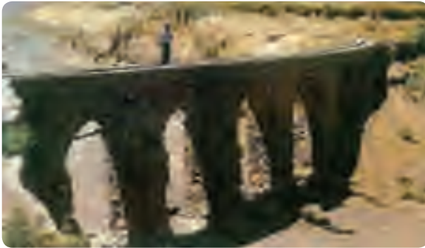
شکل ۳۳-۱- بل انتقال آب قنات بر روی رود دوکالی خراتق
