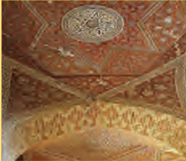
شکل ۱۴-۴- تزئینات معرق یکی از ایوان‌های گنبد سلطانیه
