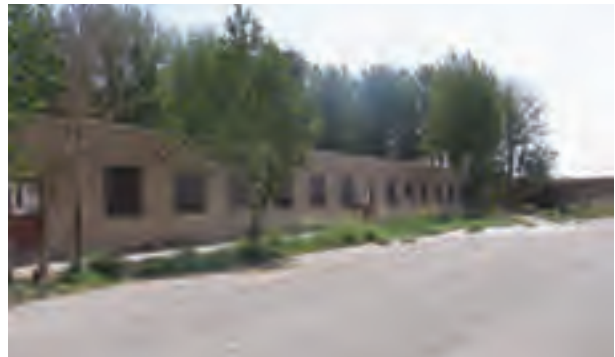
تصویر ۸-۱- پنجره‌ی دیوار جلویی (جنوبی)
