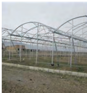
اسکلت گلخانه به سبک تونل - پیوسته
